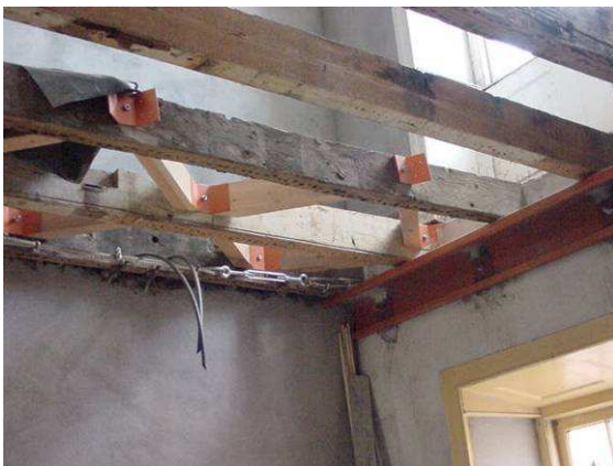
Figura 28 – Apoios das paredes ao longo da sua altura [10]
