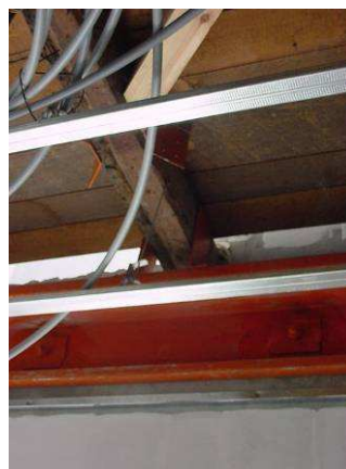
Figura 23 – Cantoneira usada em toda a envolvente da construção para assegurar a ligação entre todas as paredes [21]
