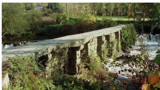
Figura 32 - Vista geral da antiga passagem existente
