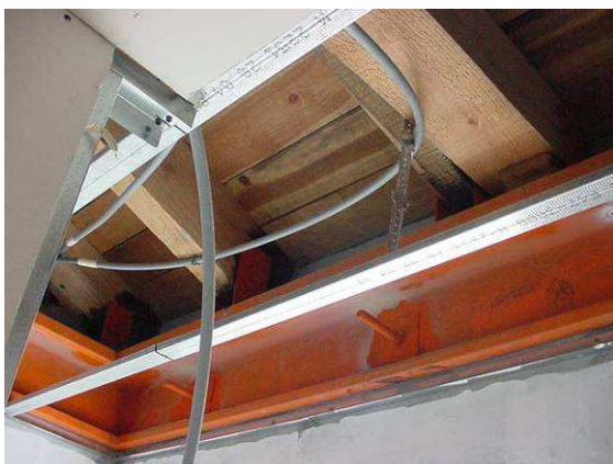
Figura 23 – Cantoneira usada em toda a envolvente da construção para assegurar a ligação entre todas as paredes [21]
