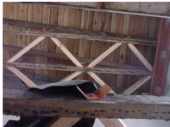
Figura 28 – Apoios das paredes ao longo da sua altura [10]
