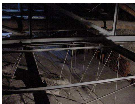
Figura 21 – Reforço dos arcos e atirantamento dos contrafortes (Igreja do Bonfim – Projecto do Prof. Joaquim Sarmento)
