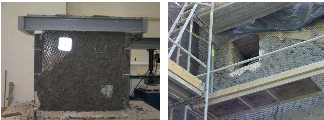
Figura 30 – Reforço de paredes de alvenaria com malha de aço inox [16]
