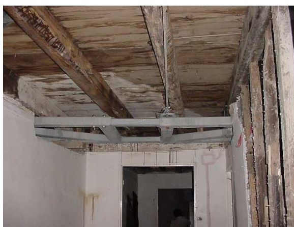
Figura 22 – Estrutura metálica para assegurar a ligação entre todas as paredes da construção
