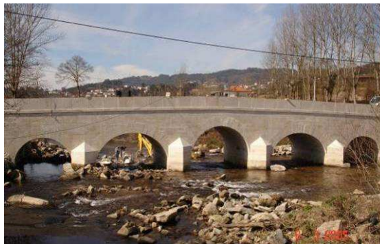
Figura 34 - Aspecto final geral da nova ponte (montante)
