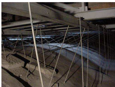
Figura 21 – Reforço dos arcos e atirantamento dos contrafortes (Igreja do Bonfim – Projecto do Prof. Joaquim Sarmento)
