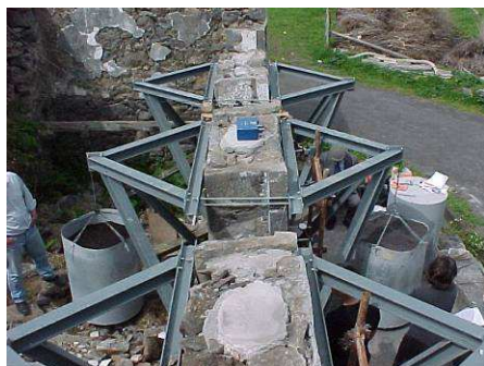
a) Ensaio no Faial em paredes de alvenaria de moradias
