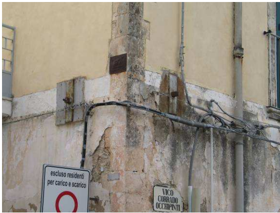
Figura 19 - Utilização de tirantes para ligar paredes
