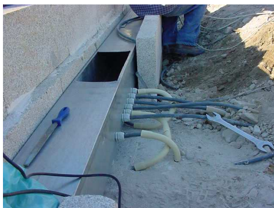
Figura 49 - Aspecto da calha técnica
