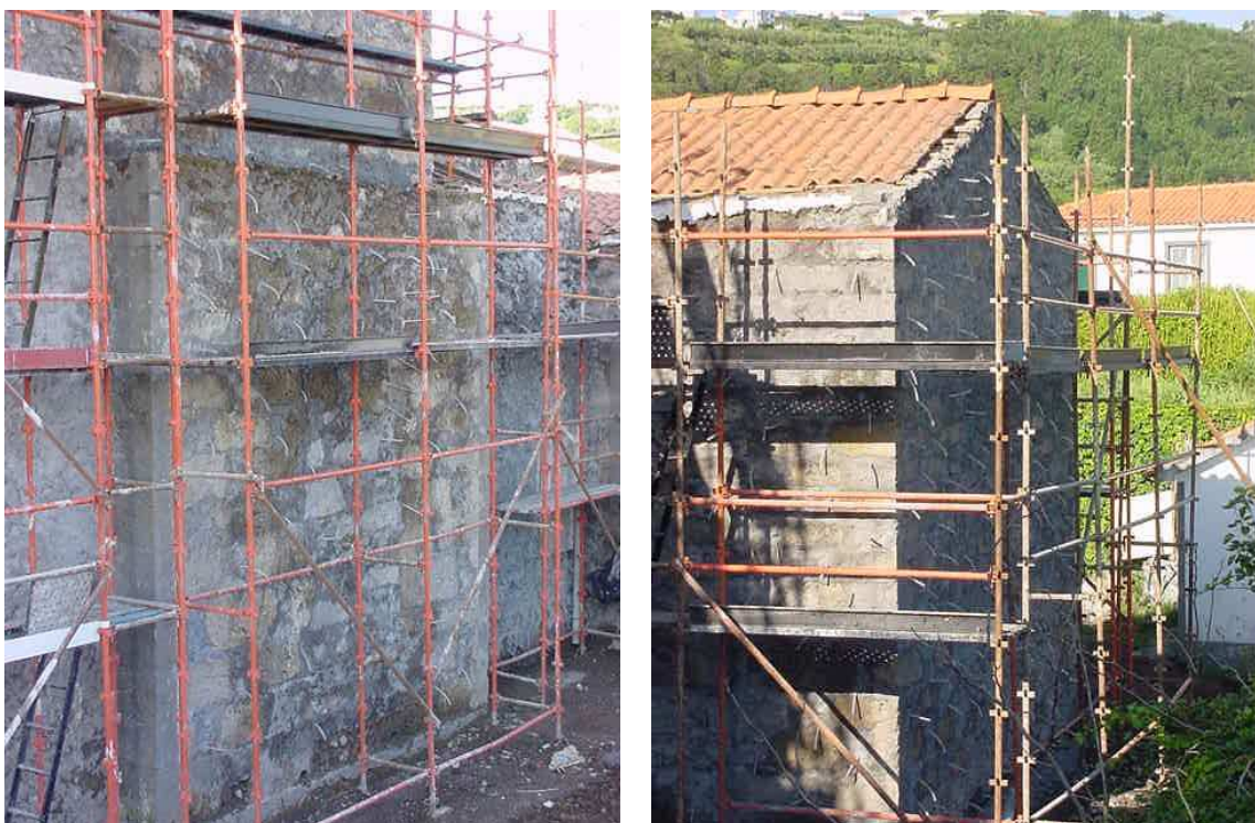
Figura 31 – Injecção em paredes de alvenaria de pedra
