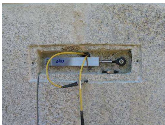
Figura 40 - Instrumentação de juntas. Transdutor de deslocamento de fibra óptica.
