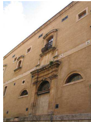
Figura 19 - Utilização de tirantes para ligar paredes
