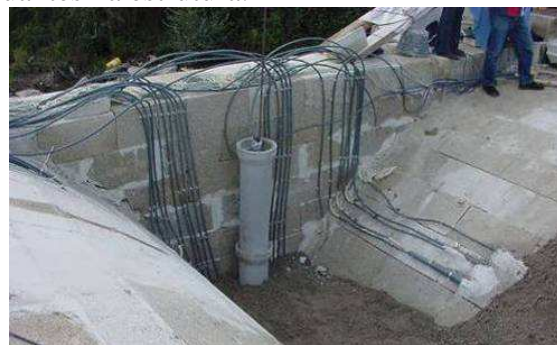
Figura 38b - Colunas de apoio aos sensores de pressão (vista geral na fase de construção).
