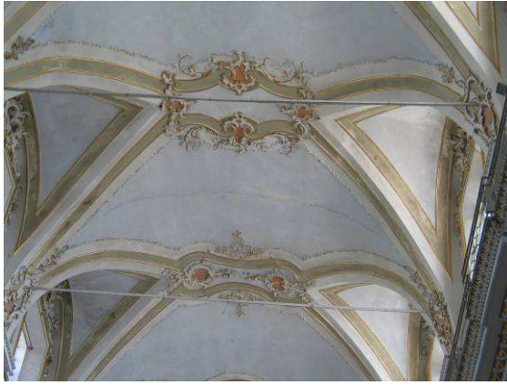
Figura 26 – Tirantes para absorver as componentes horizontais dos impulsos
