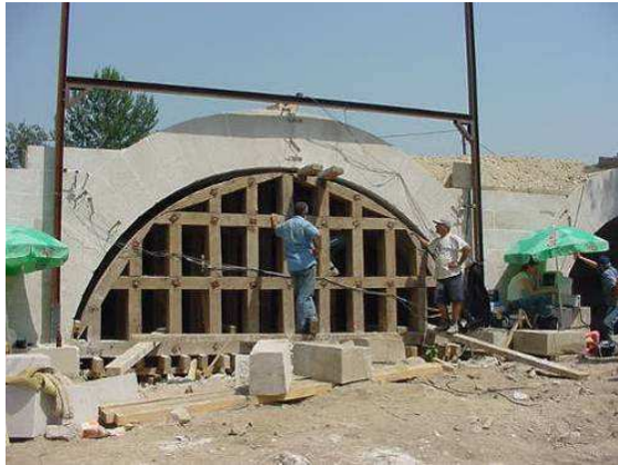
Figura 35a- Descimbre de um arco. Pórtico de referência para comparadores e LVDT's.
