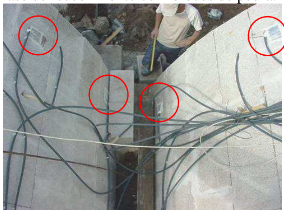
Figura 44 - Colocação de extensómetros. Vista geral em fase de recobrimento com pedra do tímpano.
