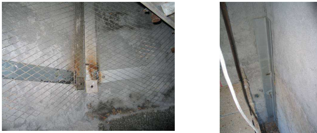
Figura 24 – Ligações entre elementos estruturais [9]
