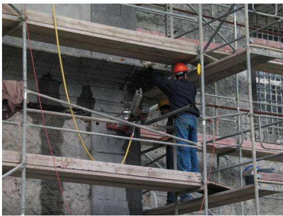
Figura 20 – Utilização de tirantes para ligar paredes
