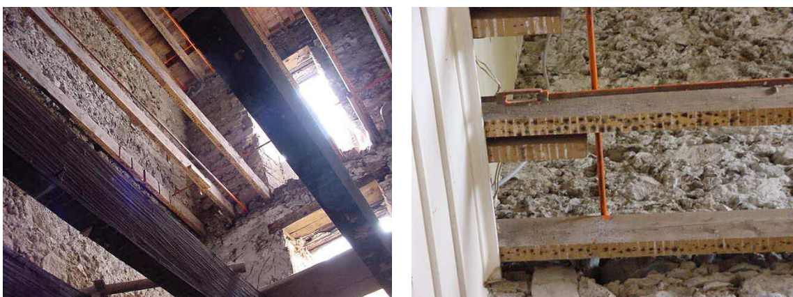
Figura 18 – Utilização de tirantes para ligar paredes
