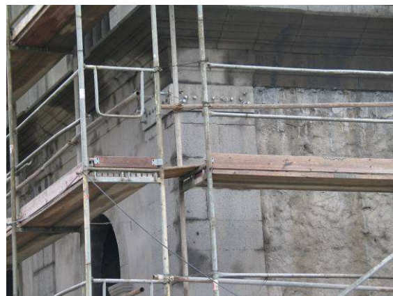
Figura 20 – Utilização de tirantes para ligar paredes
